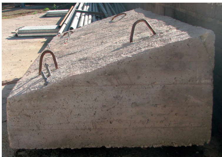
Fig. 6.2-7 Esempio di struttura di ancoraggio – Vista laterale
