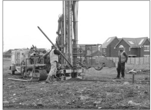
Inserimento e montaggio asta di perforazione
