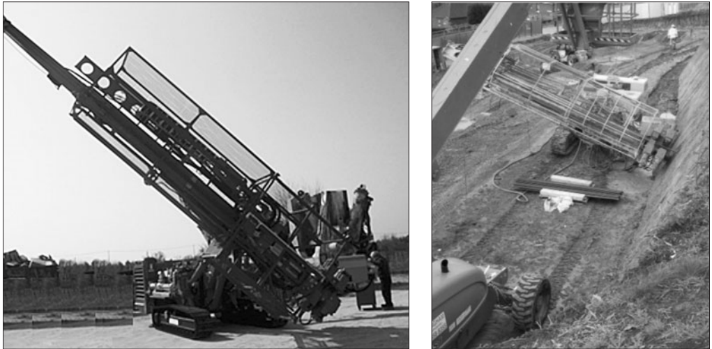
Fig. 6: Perforazioni oblique ed orizzontali
