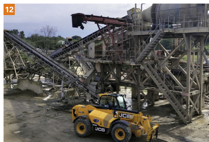
Figure 12-13: Interventi di manutenzione impianti
